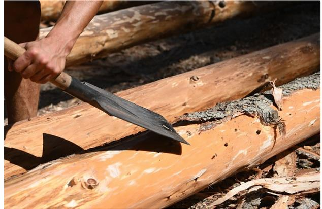
*Ecorçage des troncs de cèdre de la forêt du terrain pour la charpente*
