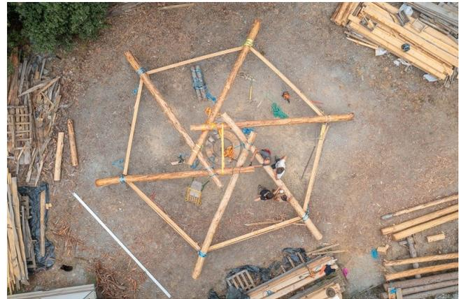
*Charpente réciproque d'abord montée au sol pour s'entraîner !*
