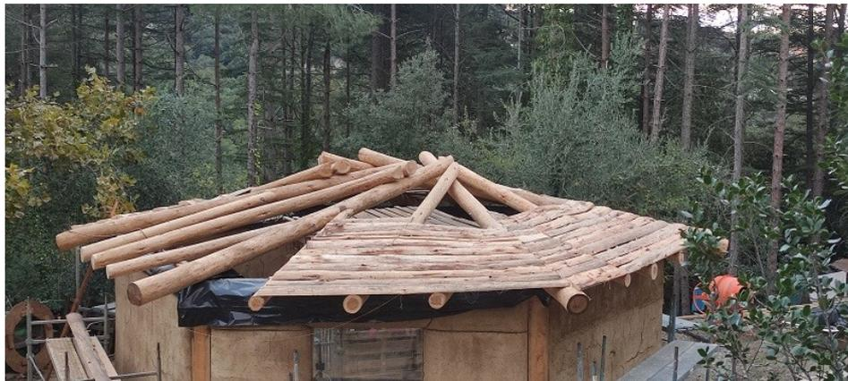
*Pas de gaspillage de bois, recouvrement de la charpente avec les dosses de sciage du bois servant à la construction des murs*
