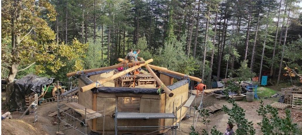
*Une plate forme de palettes est construite au centre ainsi que la pose du « charlie stick » poteau provisoire où le premier arêtier est posé.
